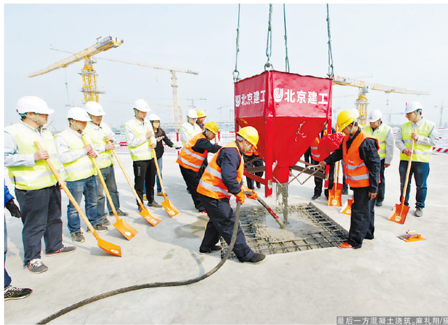
最后一方混凝土浇筑，顺利封顶
