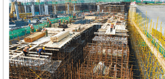
国庆节期间施工人员检查中南指廊外脚手架
