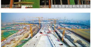
主体结构全面封顶
