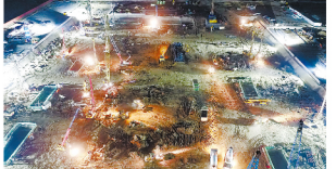
中南指廊夜间施工
