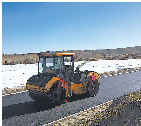
现场正式道路取代临时道路。
