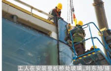
工人在安装登机桥处作业。刘东旭/摄
