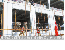
北京学校项目进入施工冲刺阶段。代德明/摄
