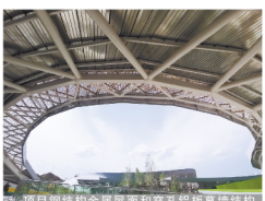
项目钢结构金属屋面穿孔铝单板幕墙结构
