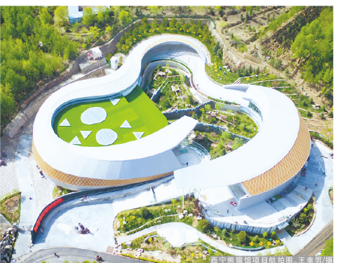
西宁熊猫馆项目航拍图。王季勇/摄
