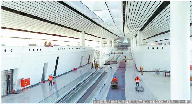
大兴国际机场航站楼指廊工程正在冲刺6.30竣工目标。张一佳/摄
