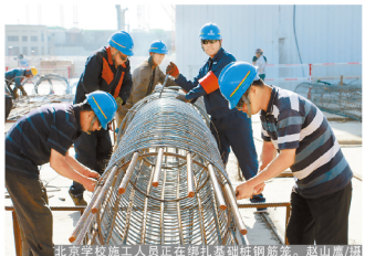
北京学校施工队正在绑扎基础钢筋笼架。赵山鹰/摄
