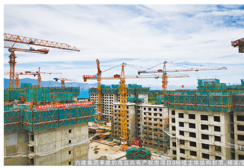
六建集团承建的海淀共有产权房项目9栋楼主体结构封顶，标志着...
