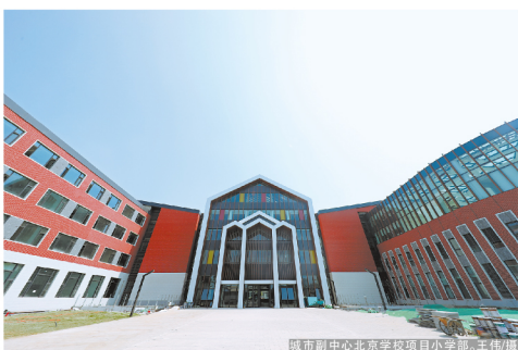
城市副中心北京学校项目小学部主楼施工现场
