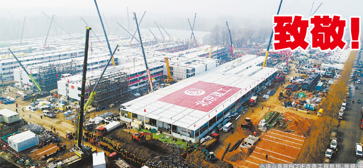
小汤山医院BCDE改造工程施工航拍,徐敏/摄
