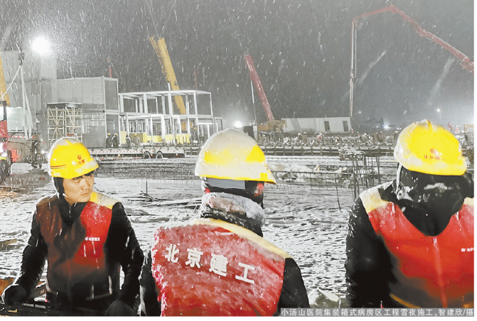
小汤山医院集装箱式病房区工程雪天施工。智建政/摄
