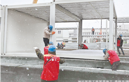
地坛医院工程雪天施工。李晓宇/摄
