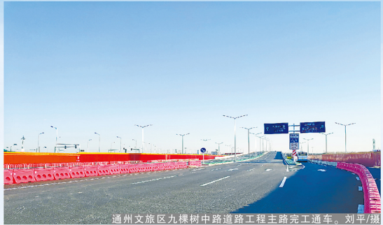
通州文旅区九棵树中路道路工程主路完工通车。刘平/摄
