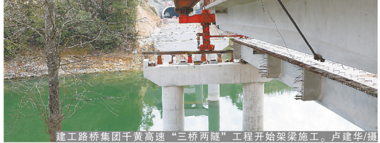
建工路桥集团千黄高速“三桥两隧”工程开始架梁施工。卢建华/摄
