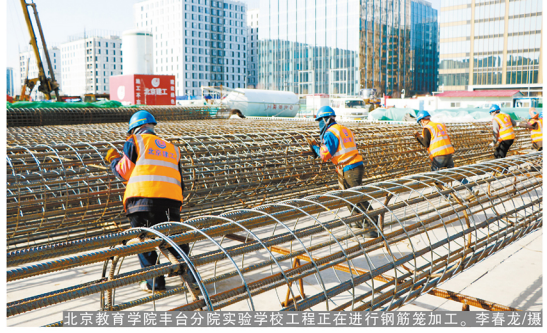
北京教育学院丰台分院实验学校工程正在进行钢筋笼加工。李春龙/摄
