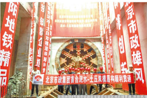
沈阳地铁4号线项目劳望区间右线顺利贯通(刘欣然摄)
