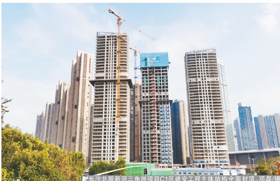
长沙北辰新河三角洲项目C1区建安工程主体结构全面封顶。邓磊/摄
