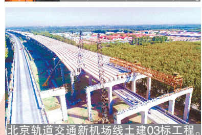
北京轨道交通新机场线土建03标工程。
