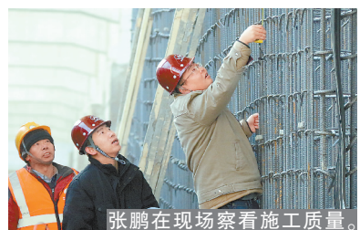
张鹏在现场察看施工质量。
