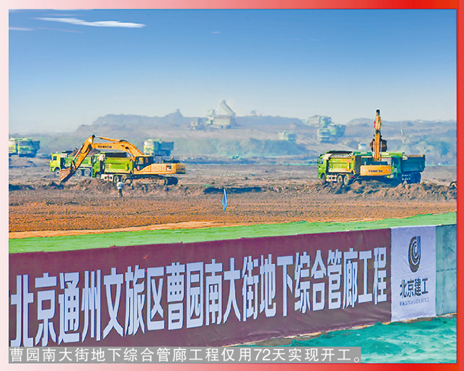
曹园南大街地下综合管廊工程仅用72天实现开工。
