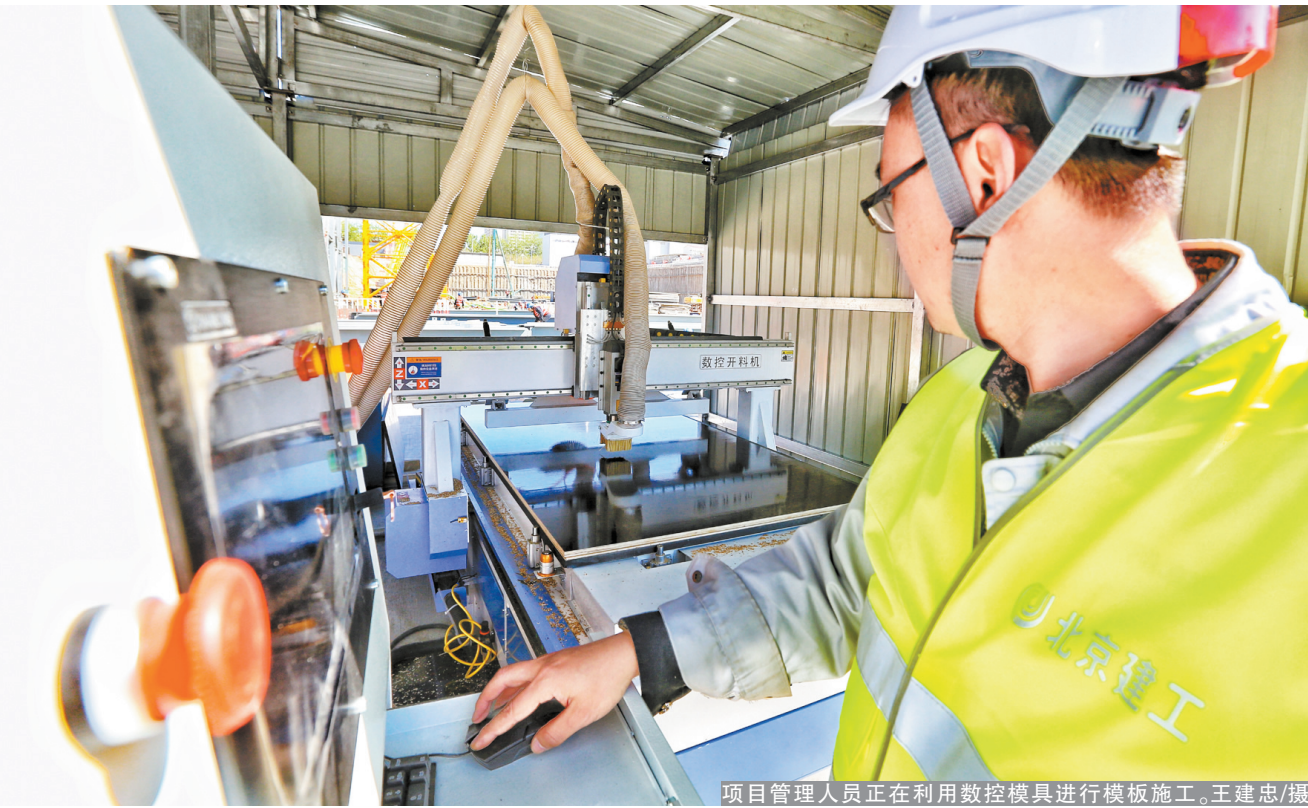
项目管理人员正在利用数控模具进行模板施工。王建忠/摄
