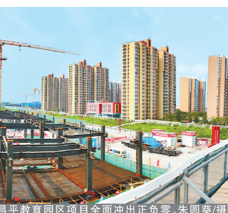
好未来昌平教育园区项目全面冲出正负零。朱国葵/摄
