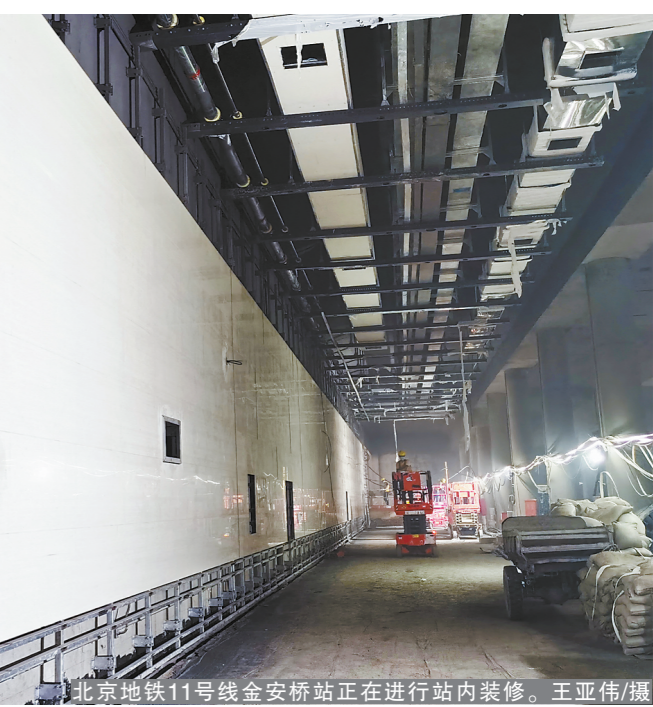
北京地铁11号线金安桥站正在进行站内装修。王亚伟/摄
