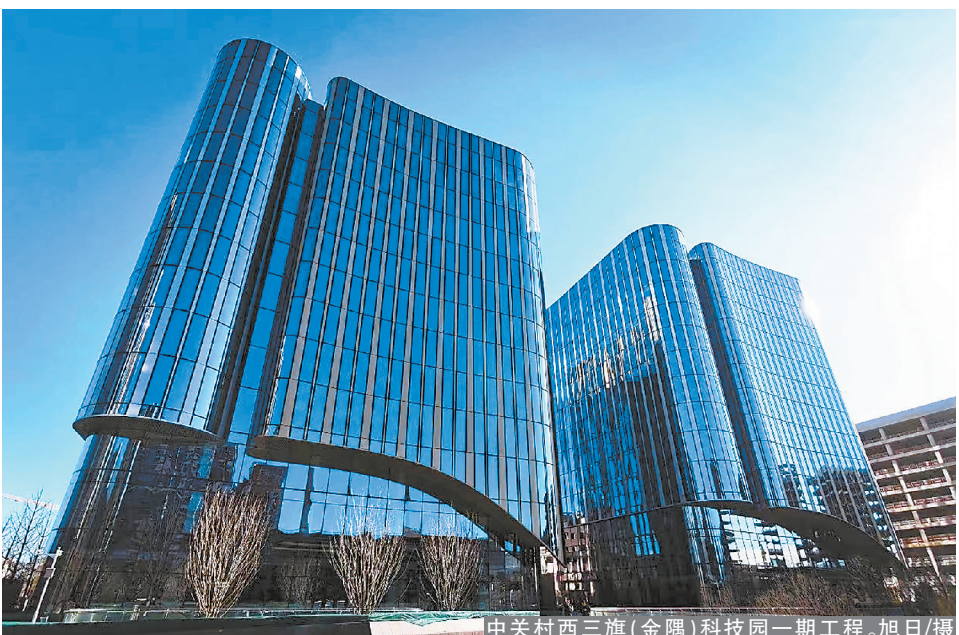
中关村西三旗(金隅)科技园一期工程。旭日/摄
