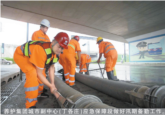
养护集团城市副中心(丁各庄)应急保障段做好汛期备勤工作。
