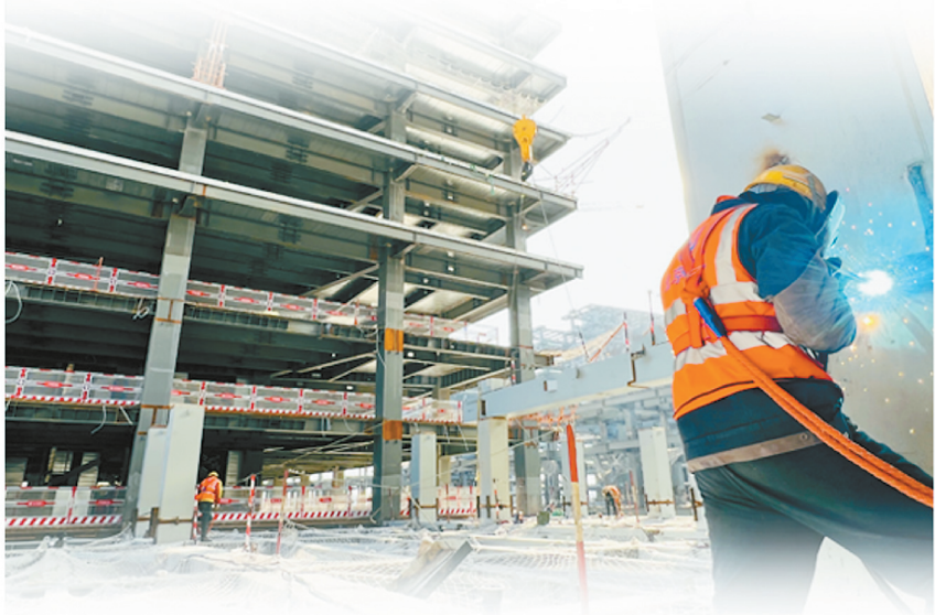
中关村东升科技园二期项目施工人员正在进行钢结构施工。关旭/摄
