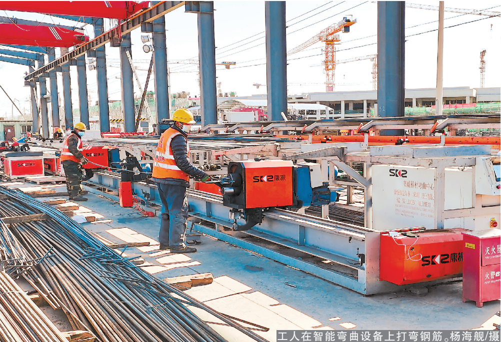
工人在智能弯曲设备上打弯钢筋。杨海舰/摄
