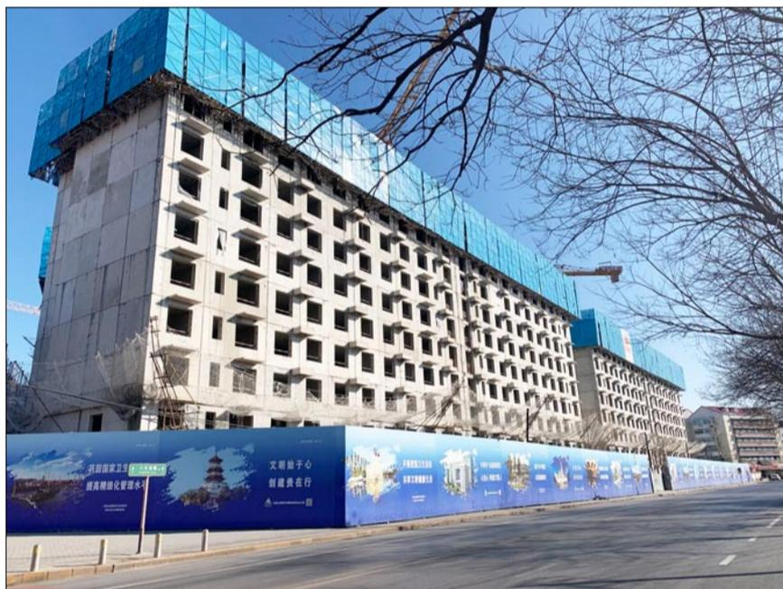
够及时发货,项目还派职工在构件厂驻场,及时跟进构件厂发货情况,以确保预制构件能够及时准确发货。在施工过程中,项目部基本可以做到6天施工一层的速度,最快可以达到5天一层,最终通过项目部不懈的努力,确保了石景山东下庄工程在1月16日顺利完成全部7个栋号封顶的目标。
