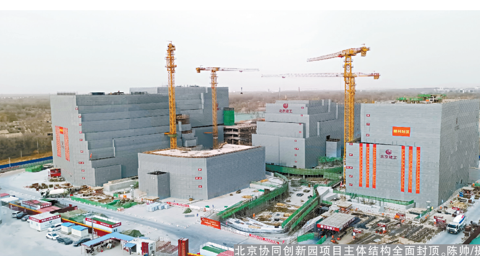
近日，由集团承建的北京协同创新园项目主体结构全面封顶。该项目坐落于海淀苏家坨地区，是海淀区苏家坨镇“一镇一园”的重点示范项目，同时被纳入北京市2021年“3个100”重点工程，由4个单体建筑组成，建成后聚集各类高
