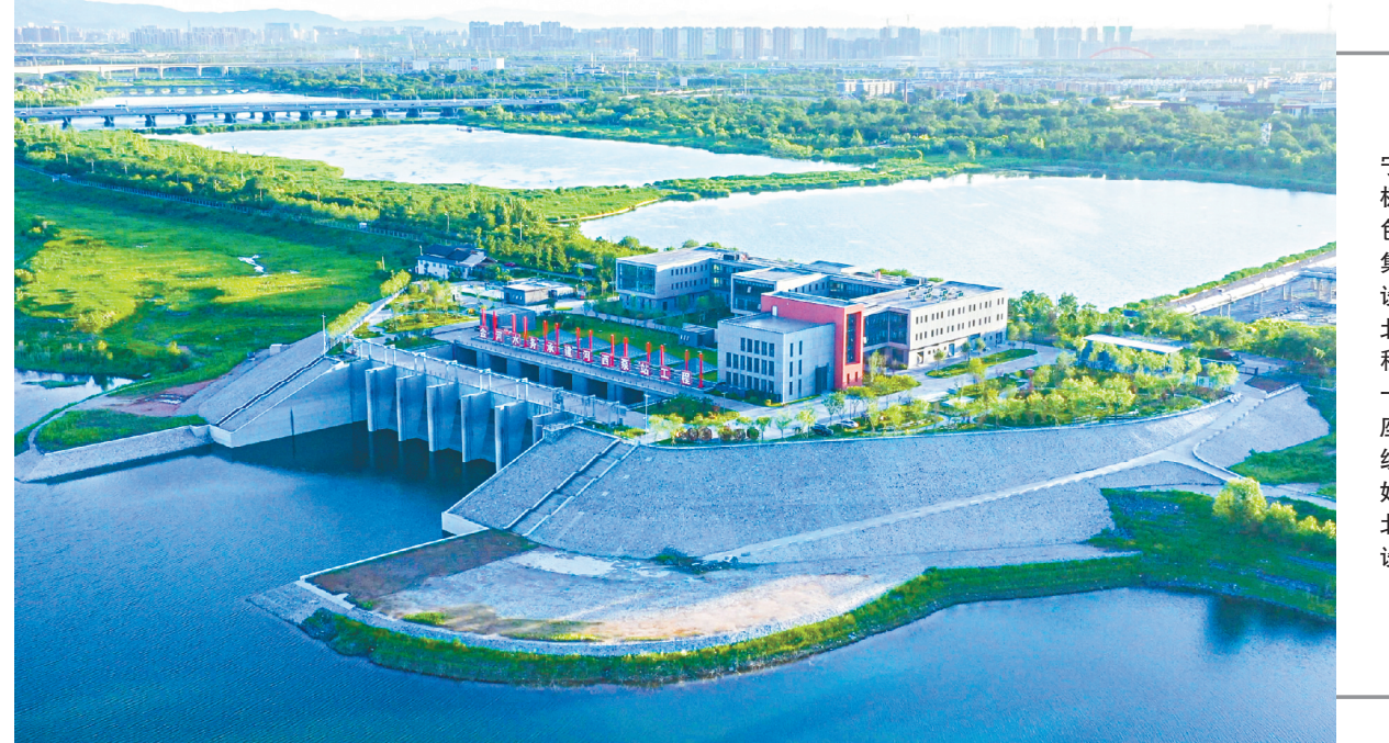
西五环外，大宁水库东侧，一片极具现代感的灰色建筑是由城乡集团金河水务承建的北京市南水北调河西支线工程之一，中堤泵站。这座泵站是河西支线梯级泵站中的始发泵站，创造了北京市水泵站建设史上多项第一。 于洪才/摄
